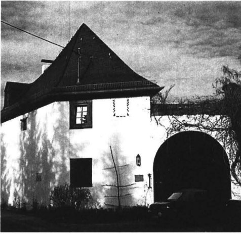
Abb. 3: Das renovierte Pfortenhaus von 1999. Aufn. P. Claus.
