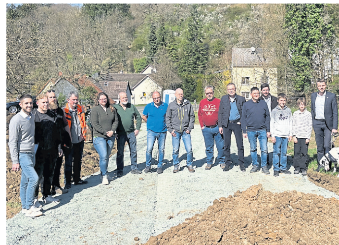
Die Baumaßnahmen für den Hochwasserschutz in Drommershausen sind gestartet. Bürgermeister Dr. Johannes Hanisch (rechts) begrüßte dazu Vertreterinnen und Vertreter des Planungsbüros, der Baufirma, der Behörden und des Ortsbeirates. Foto: Stadt Weilburg
