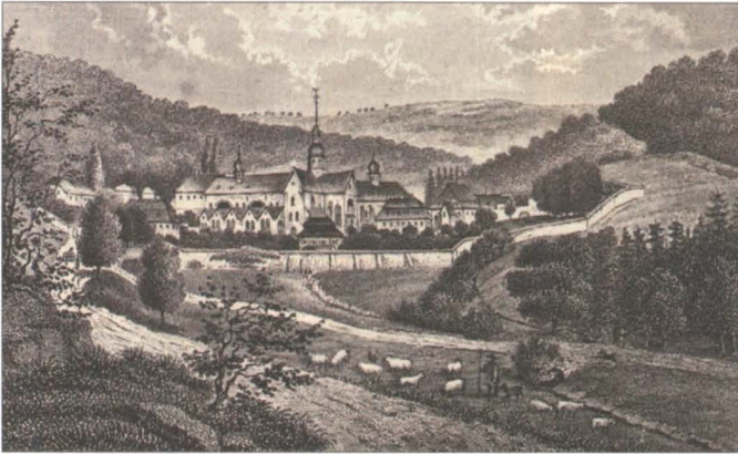
Abb. 1: Ansicht des Klosters Eberbach von Süden, aus: Herzogtum Nassau, 1862
