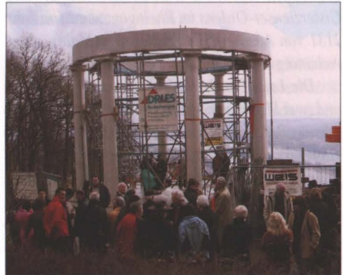
Rohbau bei der Grundsteinlegung am 25. März 2006
