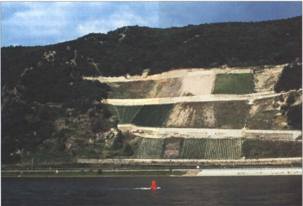
Abb. 2: Blick zum Silberberg bei Assmannshausen. In der bewaldeten Felsrippe am Rand der Weinberge in der linken Bildhälfte lag das Stollenmundloch der Bleisilbergrube. Aufnahme z.Z. der Flurbereinigung.
