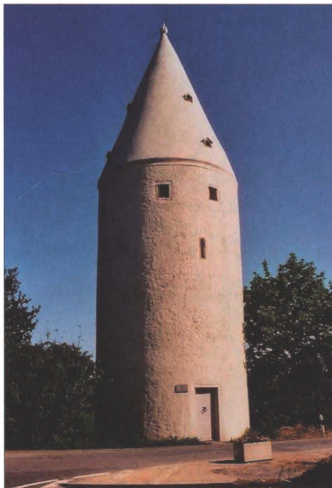
Die Erbenheimer Warte. Die ebenerdige Tür wurde erst in der Neuzeit gebrochen.
