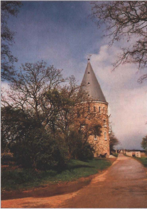
Die neue Flörsheimer Warte, Blick Landwehrweg Richtung Wicker.
