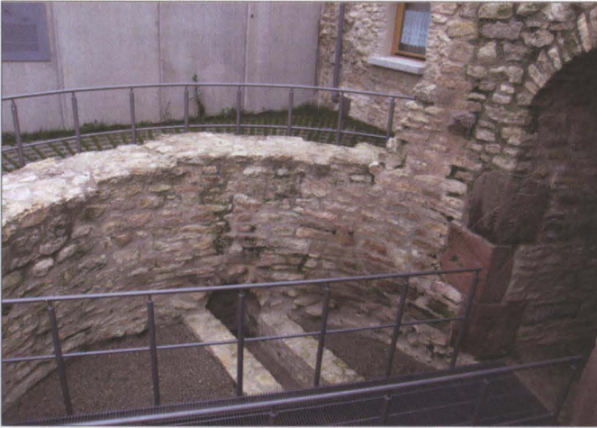
Abb. 2: Bei dem Heidesheimer Tor aus Kalk- und Sandsteinquadern ist der Einlass der karolingischen Wasserleitung freigelegt.
