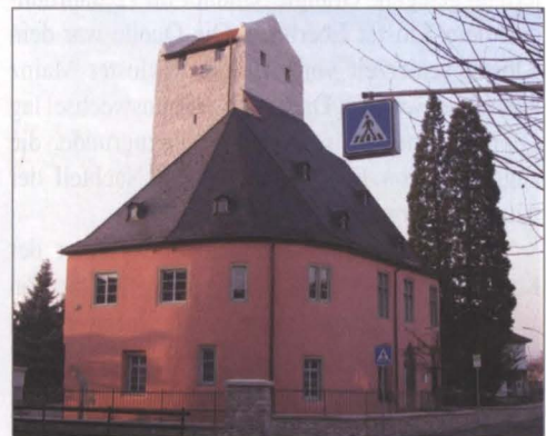
Abb. 5: Burg Windeck in Heidesheim mit Turm aus Kalksteinquadern.
