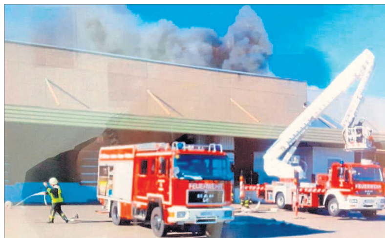
Vollbrand einer Lagerhalle in Heidesheim 2016.
