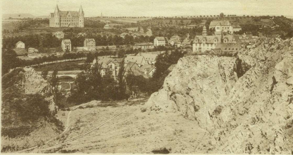
HADAMAR - Blick vom Steinbruch.
