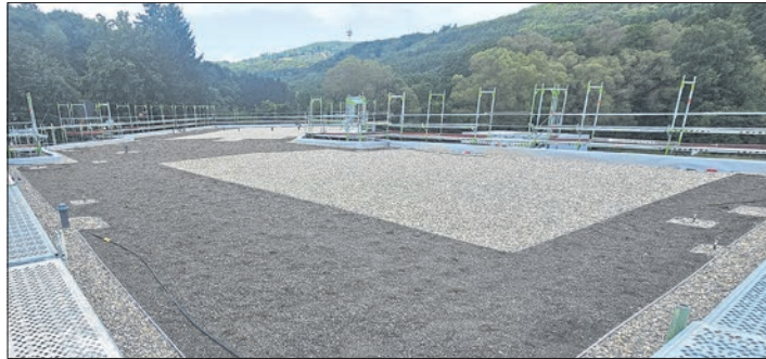
Das Dach des neuen Kindergartens in Vockenhausen ist vorbereitet für den Aufbau einer Solaranlage, die in Kürze montiert wird. Die umliegenden Flächen sind als Gründach ausgebildet, damit Regenwasser versickern kann und nicht den Kanal belastet. Foto: Stadt Eppstein
