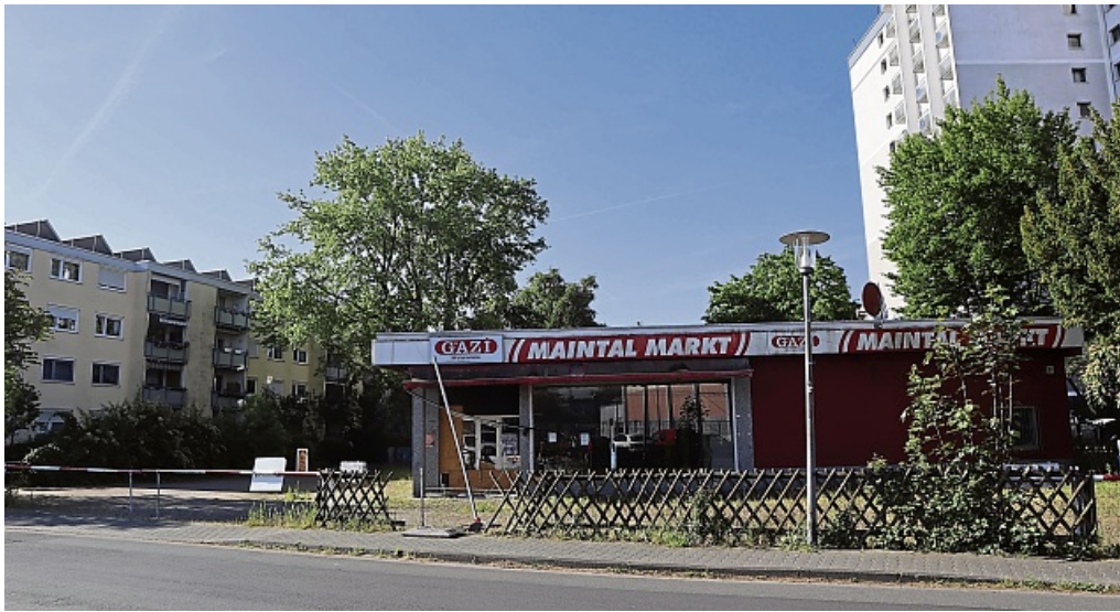
In den „Lost Place“ soll neues Leben einziehen: Der Eigentümer will auf dem Grundstück des ehemaligen Maintal-Markts Wohnungen und ein Ladengeschäft bauen. BETTINA MERKELBACH
