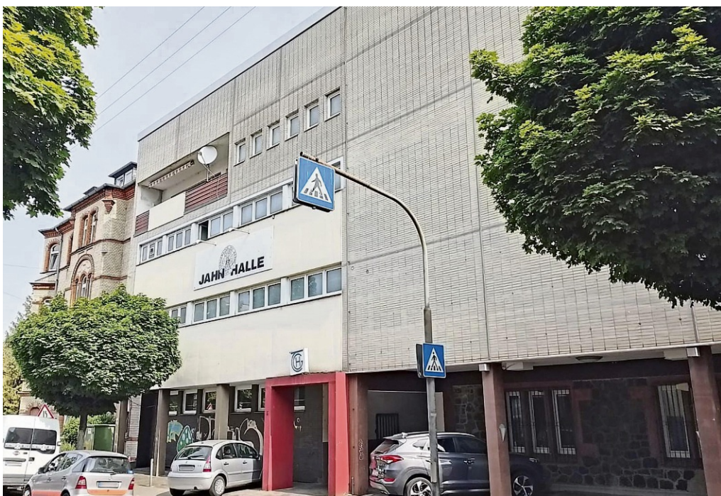
Die Jahnhalle hat ausgedient: Das 1967 eröffnete Gebäude soll perspektivisch abgerissen werden. DAVID SCHECK
