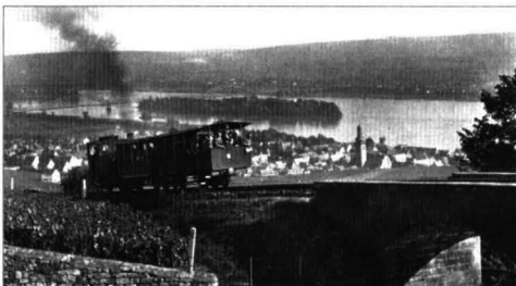
Zug bei kraftvoller Bergfahrt auf dem „Viadukt“
