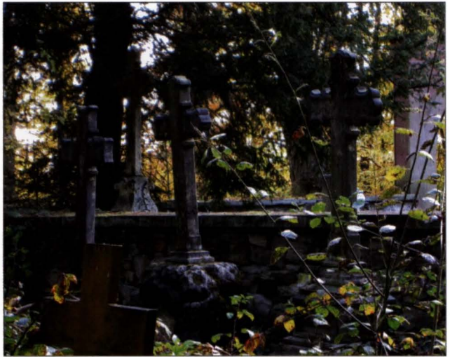
Bruchsteinmauer im südlichen Teil des Friedhofs
