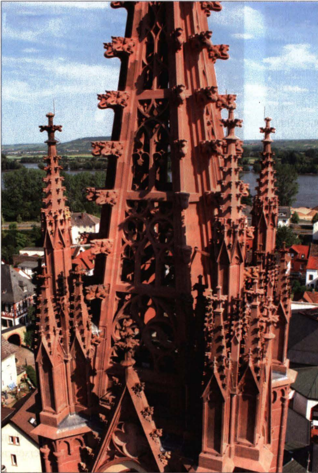
Abb. 5: Der Südturm restauriert
