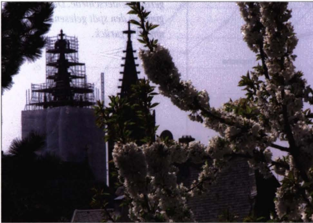
Abb. 1: Beginn der Instandsetzung am Südturm im Frühjahr 2010
