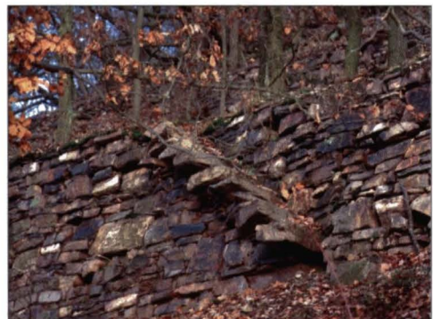
Abb. 2: Weinbergsmauer aus Taunusquarzit bei Assmannshausen. Die Treppchen wachsen nach Auflassung der Weinberge zu.
