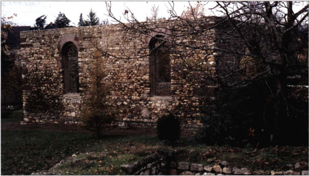
Abb. 5: Turmburg von Niederwalluf aus dem 11. Jahrhundert aus rheinhessischem Kalkstein. Ältere Aufnahme. Die sorgsam behauenen Steinlagen sind noch von der Innenseite her sichtbar.
