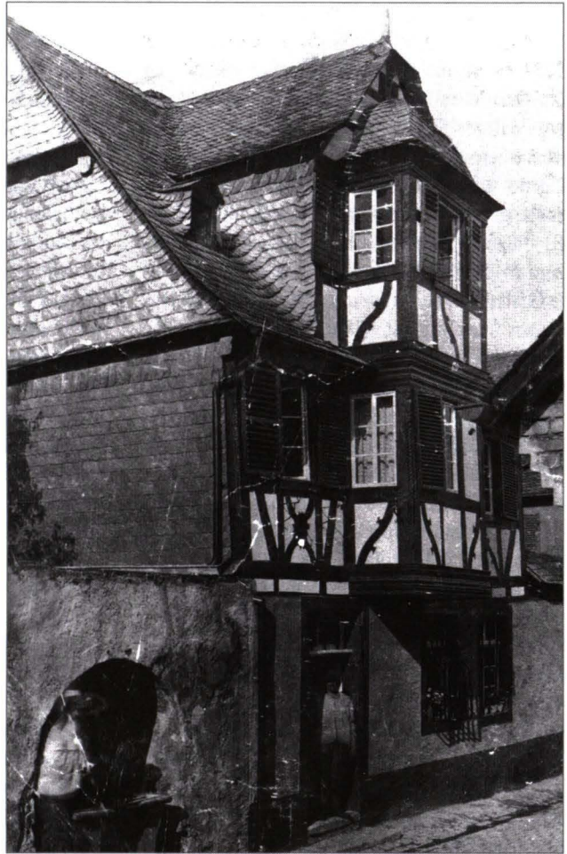
Abb. 2: St. Anna-Benefizium in Oestrich, Marktstraße 9 (um 1900). Das Erkerhaus des St. Anna-Benefiziums von 1674 musste nach dem Bombenangriff vom 2. Februar 1945 wegen Baufälligkeit abgebrochen werden. Der Brunnen im Bildvordergrund stammt laut Inschrift aus dem Jahr 1726, das Haus im Kern von 1625.
