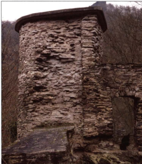
Abb. 3: Turmrest der Burg Geroldstein des 12. Jahrhunderts aus dem darunter anstehenden Hunsrück-schiefer, mit eingefügtem Ornament aus Gangquarz
