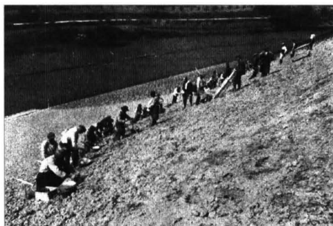
Abb. 2: Staatliche Domäne Rauenthal – Pflanzarbeiten in der Neuanlage Hühnerberg, 1925 (W. Ruthe, S. 55)
