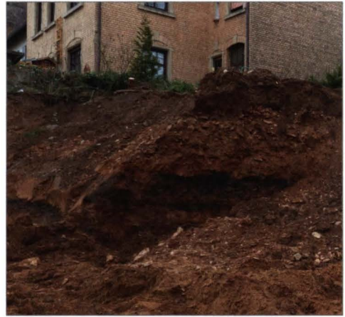
Abb. 2: Die vermeintlichen Brandspuren, die bei den Baggerarbeiten gefunden wurden.
