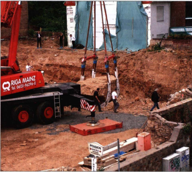
Abb. 8: Die Umsetzung des Fundamentrestes mithilfe eines Kranwagens
