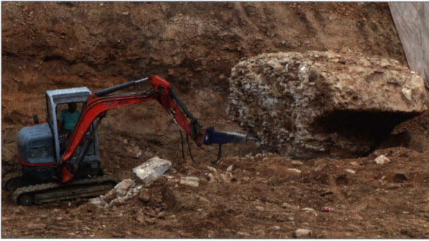
Abb. 7: Der Fundamentbrocken wird wegen seines hohen Gewichts verkleinert.
