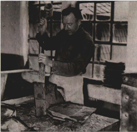
Abb. 11: Spalten der Schieferblöcke
