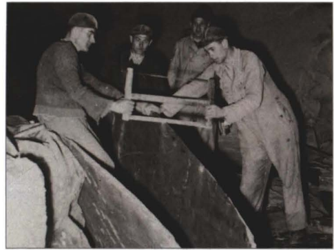
Abb. 9: Zerkleinern der Schieferblöcke unter Tage
