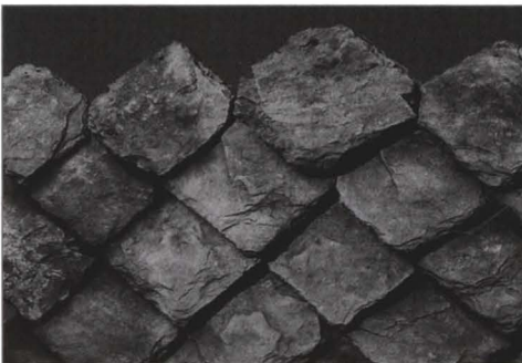
Abb. 1: Rekonstruktion eines römischen Schieferdaches
