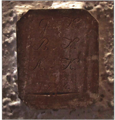
Abb. 2: Schlussstein im Kellergewölbe mit den Initialen der Bauherren und Datum 1844 – (GK, BK, AK = Georg Klindworth, Brigitta Klindworth, Agnes Klindworth)
