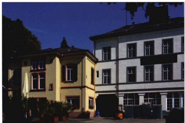
Abb. 3: Durchaus harmonisierend: Ex-Villa von 1870 plus Kellerei-Neubau von 1930 in der Bahnhofstr. 15 als gewerbliche Komponente der Gesamtanlage
