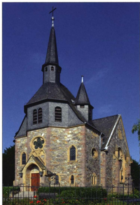
Abb. 13: Die ev. Heilandskirche von Osten gesehen bildet den nördlichen Schlusspunkt der Gesamtanlage.
