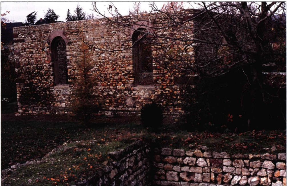
Abb. 2: Kalksteinquader der zweischaligen Mauern der Turmburg in Walluf (Vordergrund)
