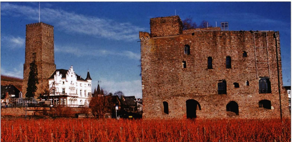
Abb. 1: Die Brömserburg Rudesheim aus Taunusquarzit („Wacken“). Die einst verbauten Werksteine aus Sandstein sind herausgebrochen.
