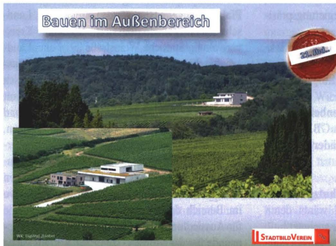
Abb. 3: Überdimensionierte Aussiedlungen in bester Weinberglage in den Gemarkungen Eltville (unten) und Hallgarten (oben)
