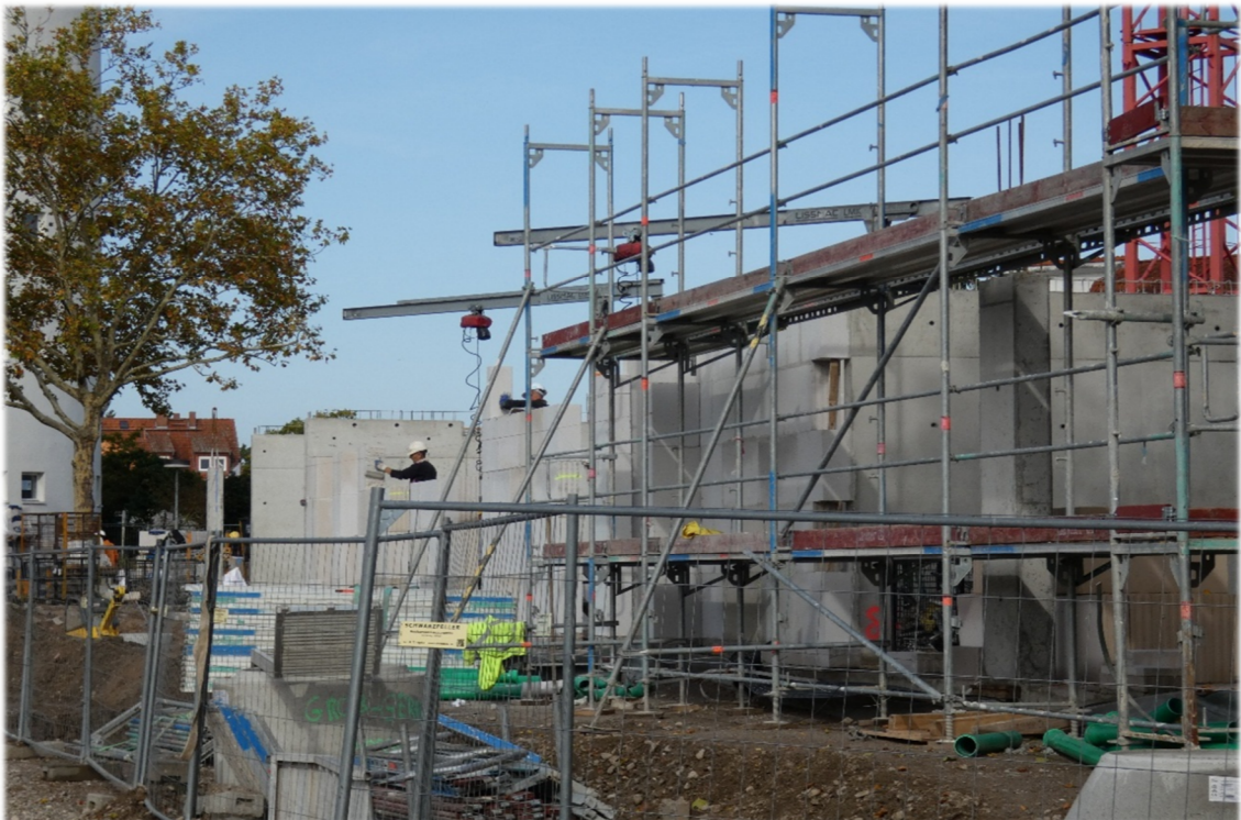
Baubegleitender Gerüstaufbau
