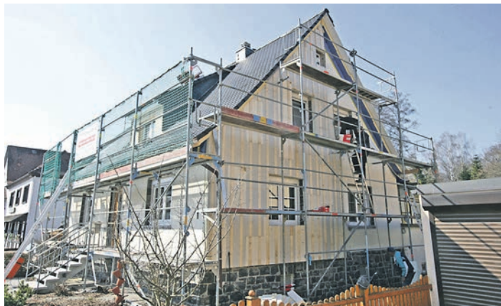
Fassadenrenovierung und Wärmedämmung in einem Schritt: So fallen Grundkosten wie das Aufstellen des Gerüsts nicht doppelt an. Foto: DJD/puren
