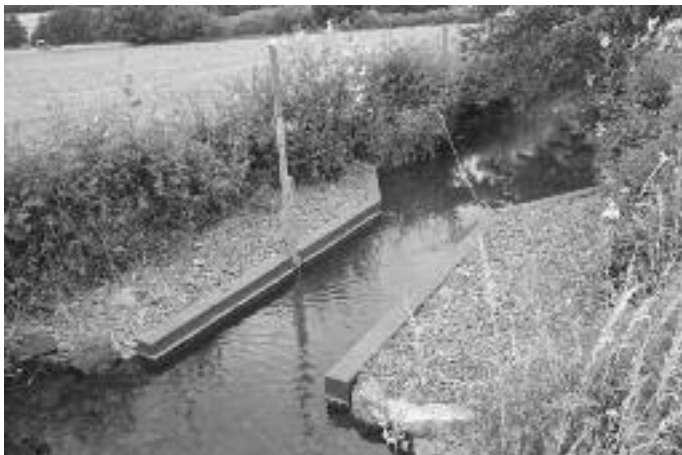
Messstelle zur exakten Abflussmessung in der Bracht Foto: Lißmann
