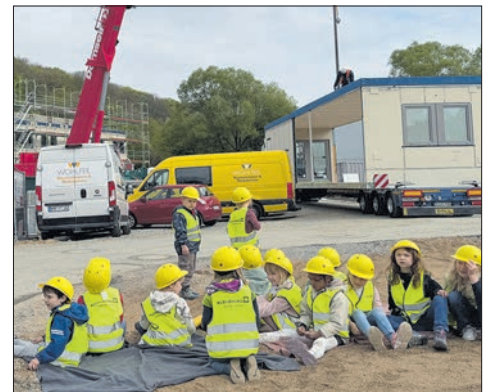
Die Kita-Kinder aus Vockenhausen beobachten im Frühjahr die Bauarbeiten und bekamen eigens kleine Sicherheitshelme dafür.
