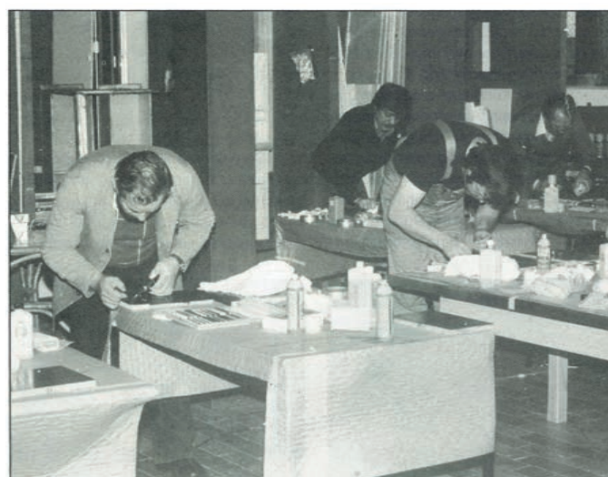
Mit modernen Materialien und Werkzeugen lassen sich Schäden bereits an Ort und Stelle beheben
