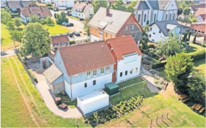
Blick auf das Gelände der Grundschule Thalau: Das Nebengebäude (vorne links) wurde saniert und durch einen Anbau erweitert. Der Altbau (rechts im Hintergrund) wurde ebenfalls saniert. Foto: Sebastian Mannert
