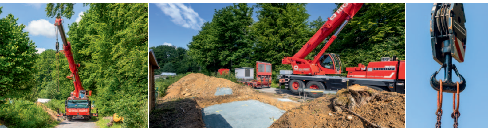
Einrichtung der neuen 630-kV-Trafostation an der Siedlung Platte im Norden von Wiesbaden.
