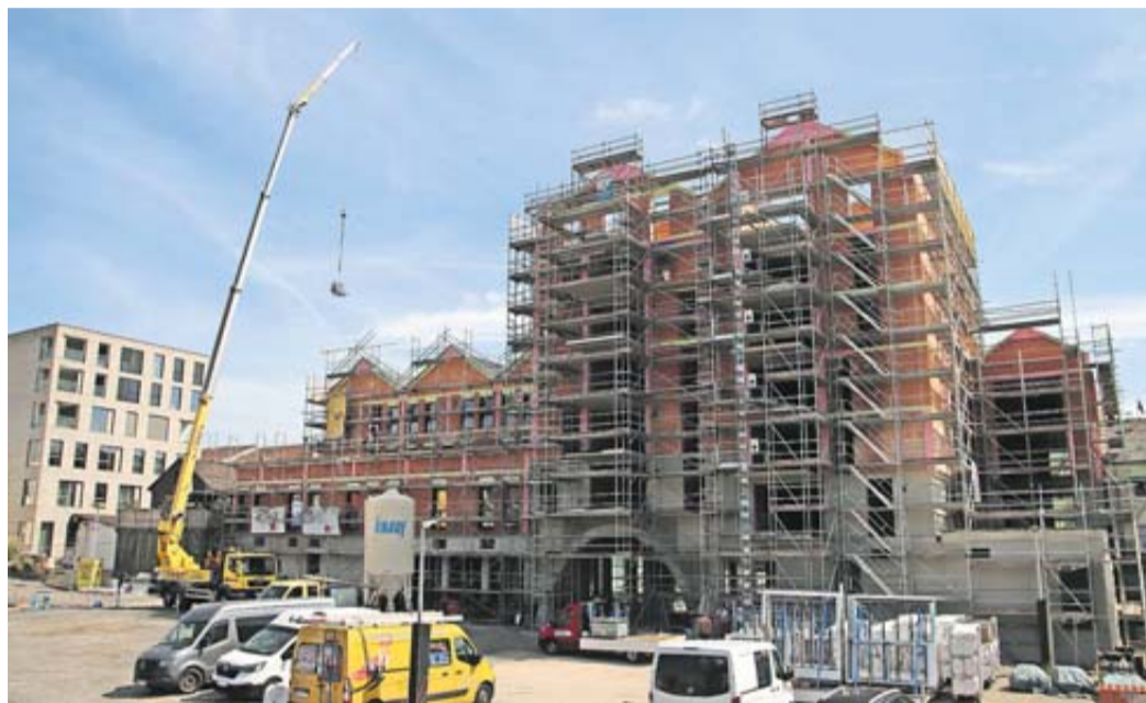
Der Rohbau für den neuen Büro- und Gewerbekomplex auf dem Langer-Areal ist fertiggestellt. Im Hintergrund links ist das Sparkassen-Gebäude zu sehen. Foto: Stadt Schlüchtern
