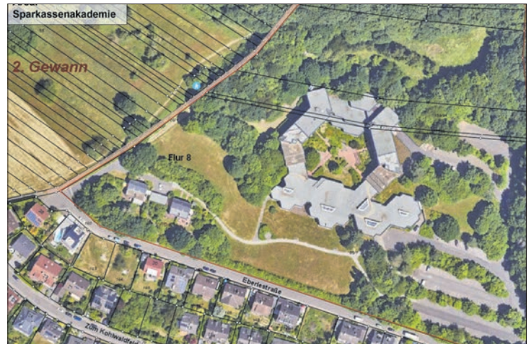
Das Areal der ehemaligen Sparkassenakademie mit dem markanten Bau am Sonnenhang von Vockenhausen. Plan: Stadt Eppstein
