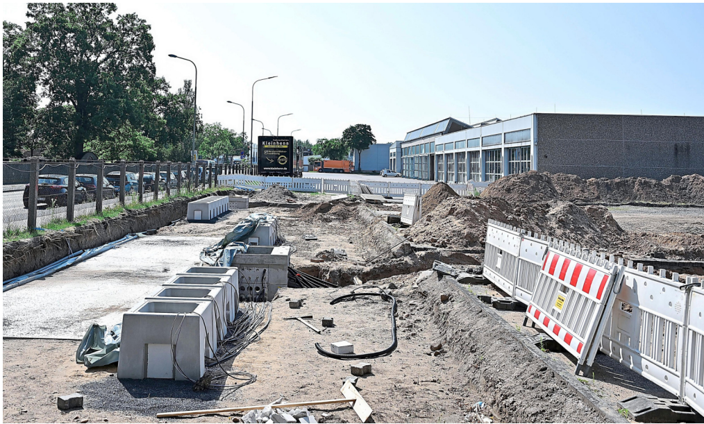
Auf dem Depotgelände der HSB an der Daimlerstraße entsteht derzeit die Lade-Infrastruktur für E-Busse.
