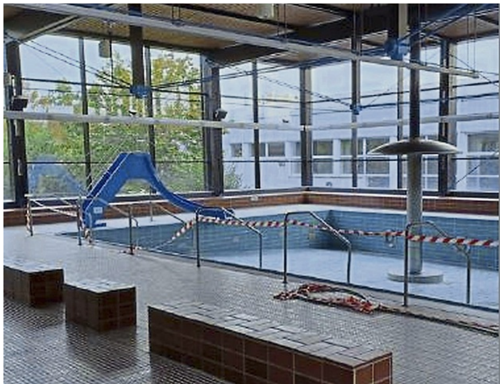
Das Erlenseer Hallenbad ist bis auf Weiteres stillgelegt. Für Untersuchungen im Rahmen der Sanierung wurde auch das Wasser abgelassen. PM
