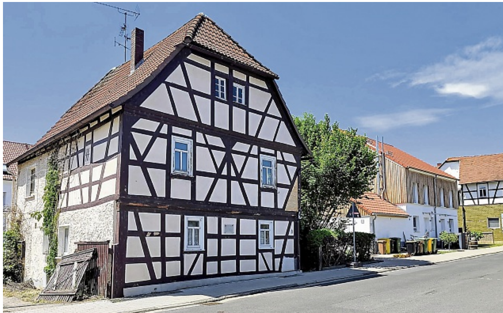
Die Bausubstanz der ehemaligen Untermühle, heute ein Einzelkulturdenkmal, soll der Überlieferung nach aus der Zeit vor dem 30-jährigen Krieg stammen.
