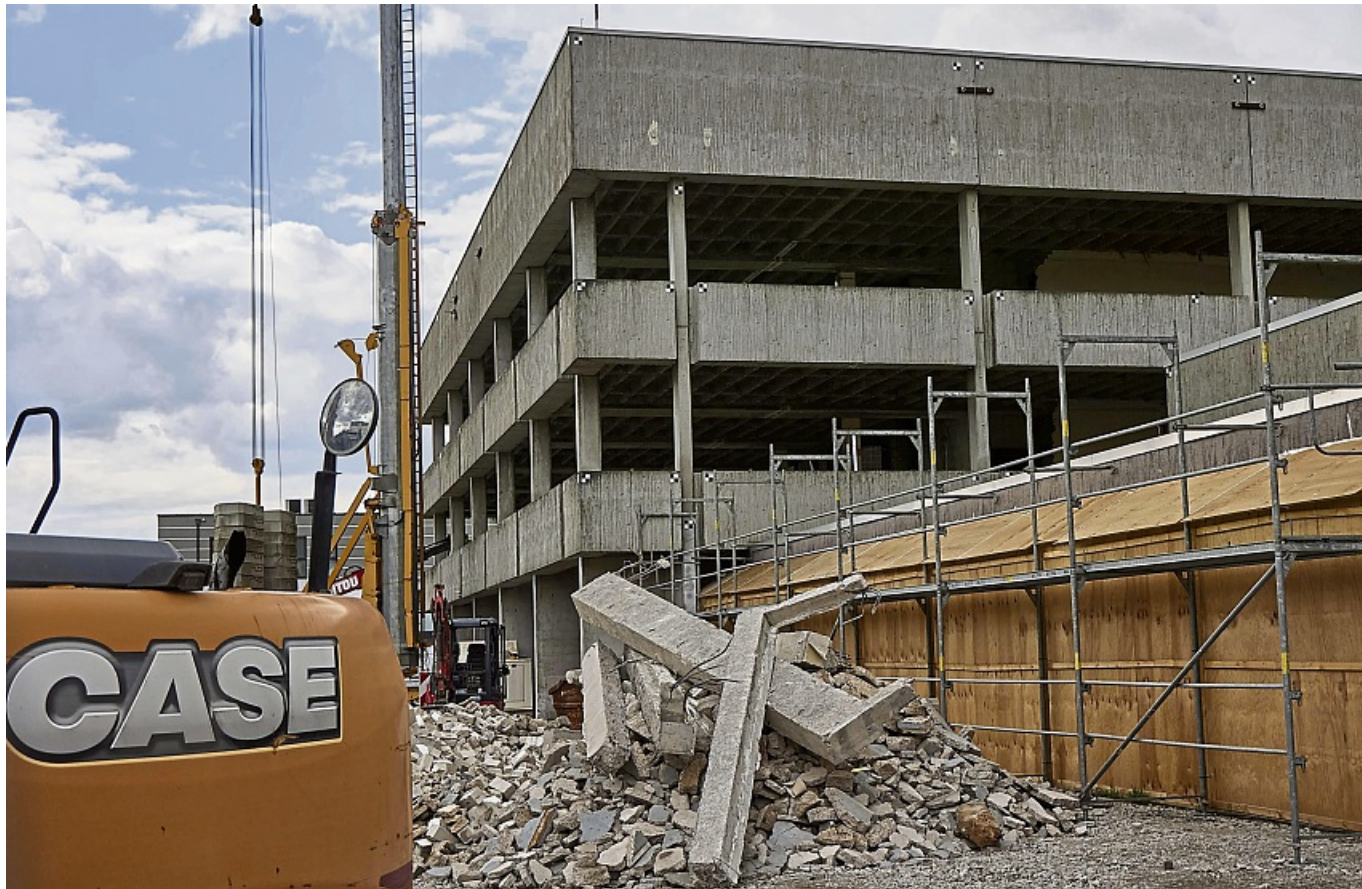
Mit dem Abriss des Anbaus mit Plenarsaal (rechts) ist begonnen worden. Zuletzt werden die Betonbrüstungen abgehängt, um das Stahlbetonskelett komplett freizulegen.
