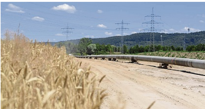
Von der Gasleitung ist später nicht viel zu sehen: Der Arbeitsstreifen wird wieder zugeschüttet. TERRANETS (ARCHIV)
