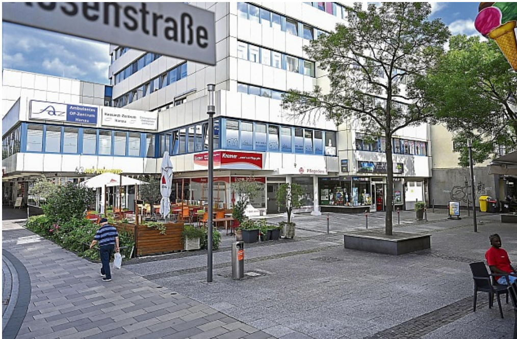
Der Bereich vom Übergang Freiheitsplatz/Rosenstraße am Freiheitsplatz wird bis Februar kommenden Jahres auf 650 Quadratmetern umgebaut.
