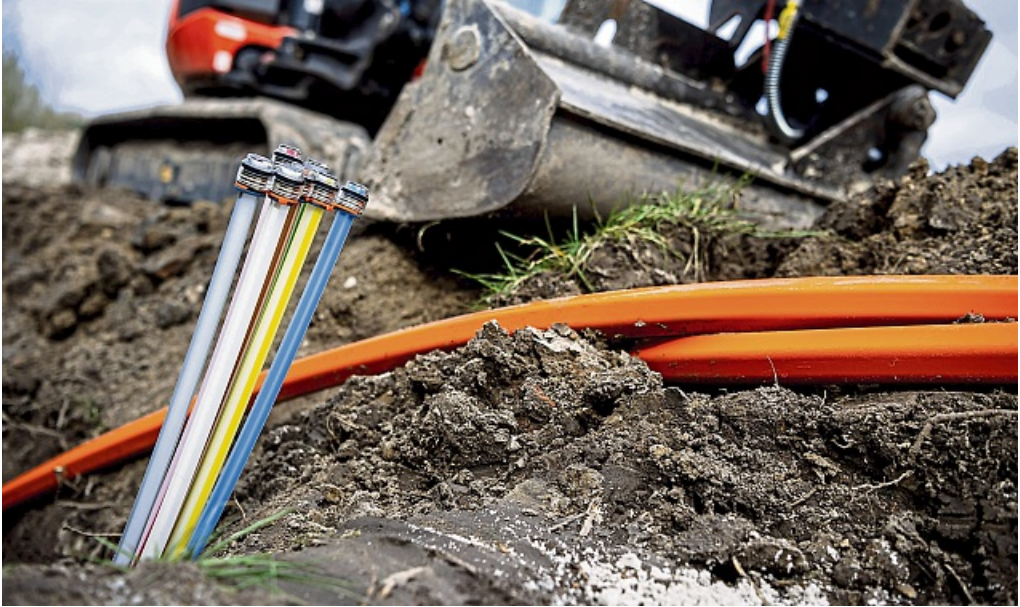
Der Ausbau des Glasfaser-Netzes in Hochstadt und Wachenbuchen liegt immer noch brach. Doch von ihrer Seite aus kann die Stadt die Zusammenarbeit mit Deutsche Glasfaser wohl nicht aufkündigen.
