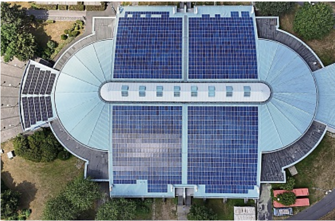
Eine neue Anlage speichert überschüssigen Solarstrom aus der Photovoltaikanlage auf dem Dach der August-Schärttner-Halle und liefert Energie rund um die Uhr. PM
