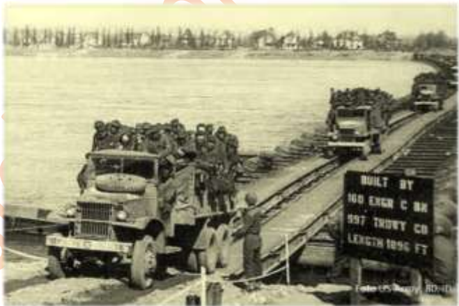
Am 26. März 1945 errichtete Ponton-Brücke bei Mainz-Kastel, die längste auf dem europäischen Kriegsschauplatz, hier mit rückgeführten Kriegsgefangenen
