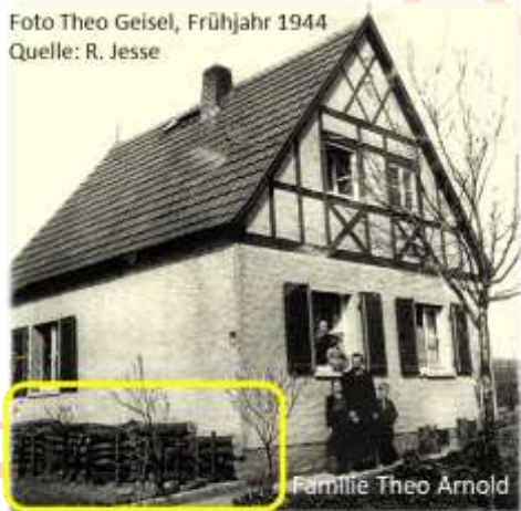
Haus Taunusstraße 8 in Usingen vor dem Brand – Vor dem Schutzkeller sind dicke Baumstämme als Splitterschutz angebracht
