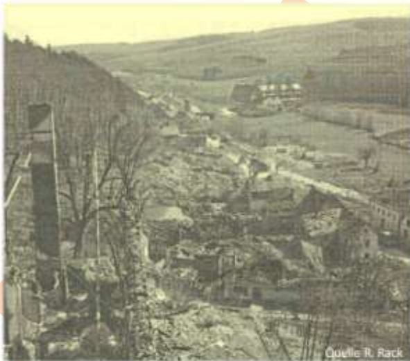
Ort und Schloss (links vorn) Ziegenberg nach dem Tieffliegerangriff am 19. März 1945, hinten die unversehrten Gebäude der Fahrbereitschaft
