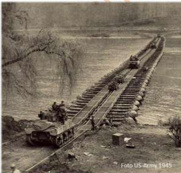
Ponton-Brücke der 87. US-Inf. Division in Boppard (Gymnasialstraße)
