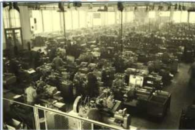
Bauteilproduktion in der 1951 errichteten Maschinenhalle
