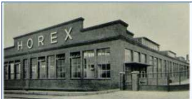
1950 errichtete Maschinenhalle mit Werkseinfahrt
