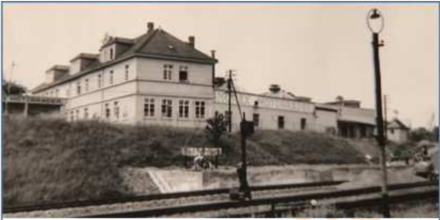
1950 geschaffene Laderampe an der Bahn, dahinter Verwaltungsgebäude
