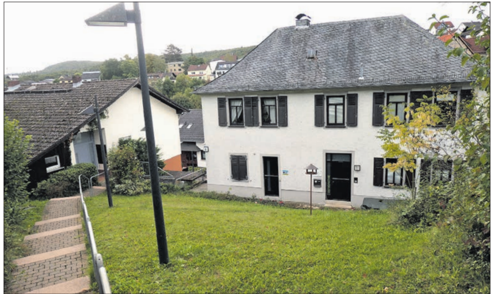
Von Bremthals Gemeindesaal (li) und Pfarrhaus (re.) auf einem Grundstück unterhalb der Kirche St. Margareta will die Pfarrei sich möglichst bald trennen. Foto: Beate Schuchard-Palmert
