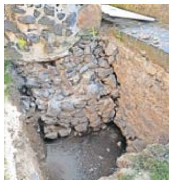
Südwestecke des Südpalas mit freigelegter Abbruchkante
