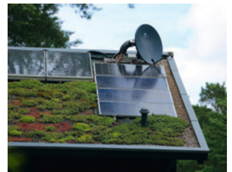
Hier passt alles drauf: Die Kombination von Gründach und Solarmodulen kann Synergien bringen. Foto: Agentur LMZ
