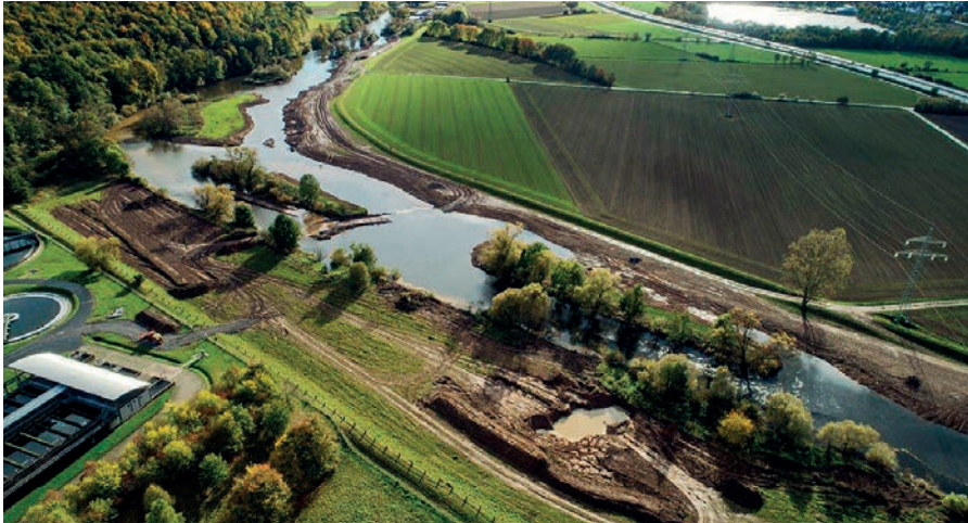
Die Renaturierung der Gisselberger Spannweite ist abgeschlossen.
