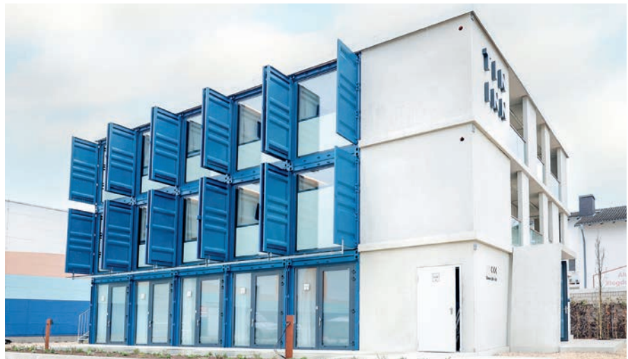
Hotel Nummer Eins: In Erkelenz entstand das erste Containerhotel von Tin Inn.
