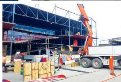
Aufbauarbeiten und Logistik an und mit dem Geisterpalast: Auf der Wiesn (hier Eindrücke aus den Jahren 2025, 2018 und 2017, v.l.) dauert es Wochen, bis die Anlage steht.
