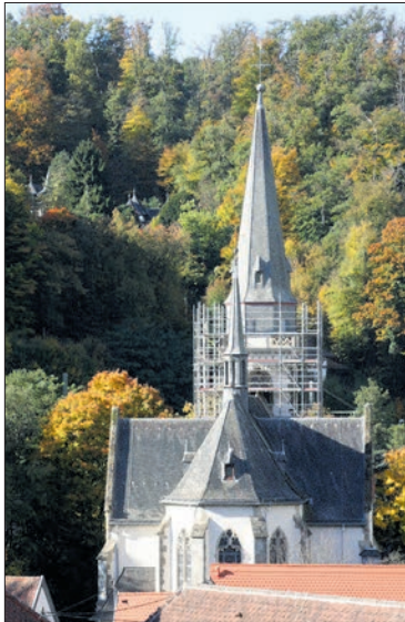
Bis Anfang November soll das Gerüst am Kirchturm abgebaut werden.
