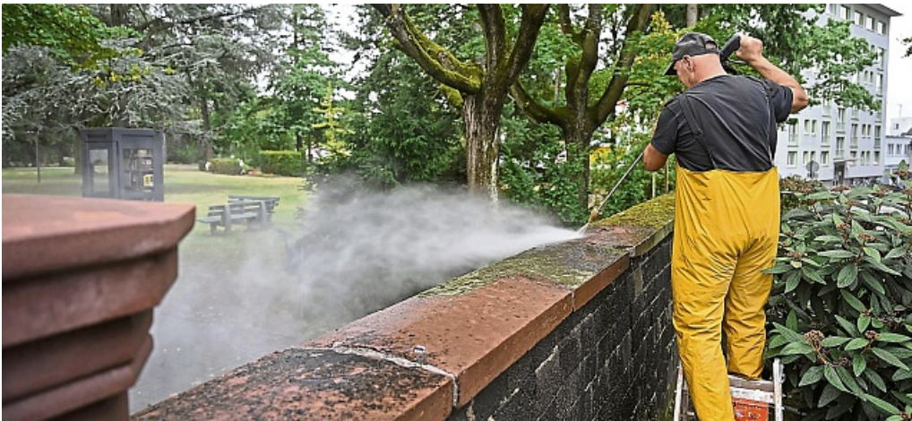
Die Arbeiten zur Reinigung und Sanierung der historischen Mauer am Hanauer Hauptfriedhof sind gestartet.
