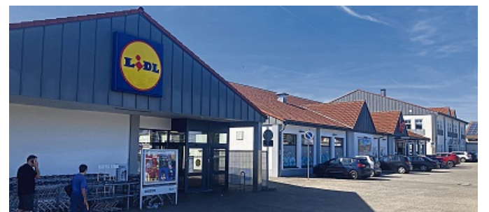
Der Lidl-Markt im Gewerbegebiet Friedberger Straße an der Kultur- und Sporthalle wird abgerissen und größer neugebaut. Das Gebiet wird insgesamt erweitert.
