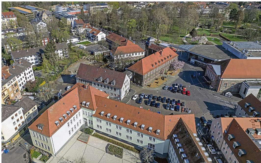
Der Schlossplatz in der Hanauer Altstadt wird in den kommenden Jahren zur Baustelle. PM
