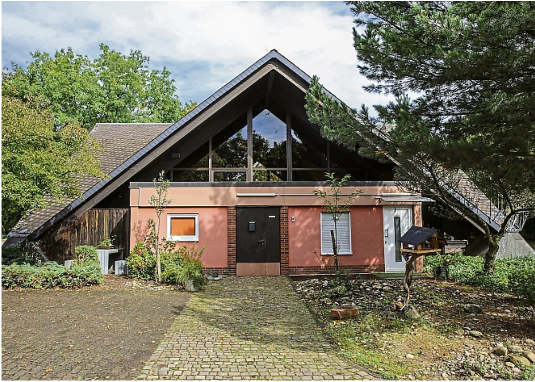
Die Trauerhalle auf dem Friedhof Rödelberg muss dringend saniert werden. AXEL HÄSLER
