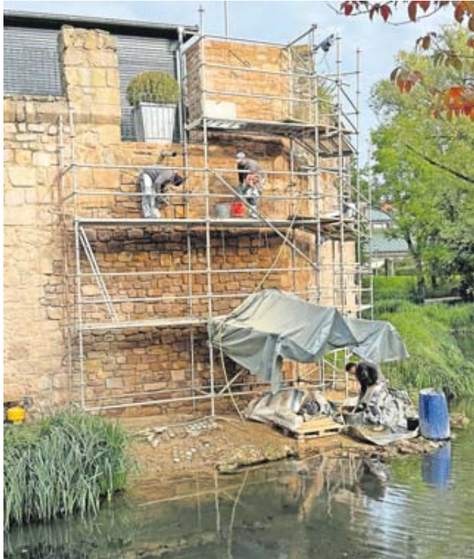
Arbeiten an der Mauer.
